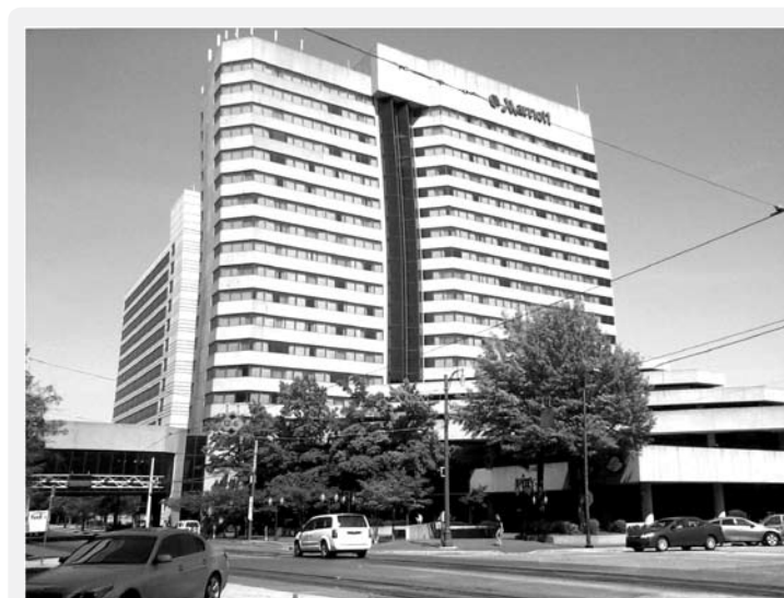
Комплекс Hotel Marriott – Convention center в городе Мемфис – штат Теннесси, где проходил симпозиум
